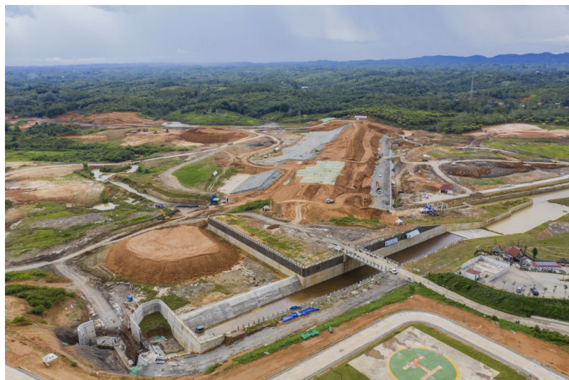
Le barrage de Sepaku Semoi en construction dans la nouvelle capitale du pays, Nusantara, surnommée IKN, à Penajam Paser Utara, dans la province du Kalimantan oriental, en Indonésie, le mercredi 8 mars 2023. L'Indonésie offre des réductions d'impôts supplémentaires et des conditions plus souples pour l'acquisition de terrains en vertu d'une nouvelle réglementation, dans le cadre de ses efforts pour attirer davantage d'investisseurs dans son nouveau projet d'investissement de 34 milliards de dollars. | Photo : Rony Zakaria/Bloomberg via Getty Images
